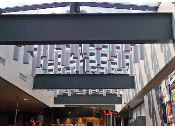
Kantoorpand OTS Group
