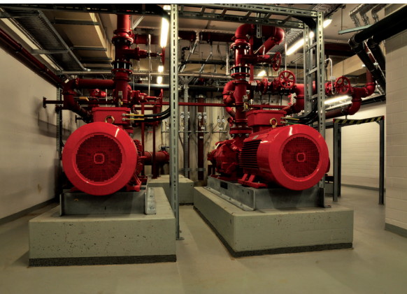
Als trillingsisolerende machinefundatie
