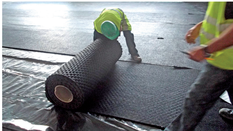
Een ruimte wordt voorzien van Regupol Sound
