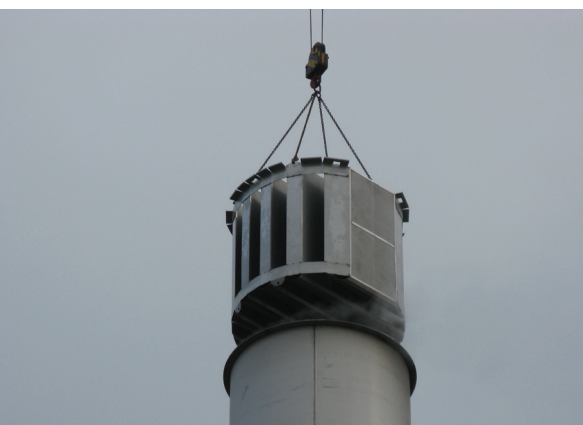
Maatwerk oplossing bestaande uit geluidsabsorberende coulissen inclusief dragende constructie voor in schoorsteen
